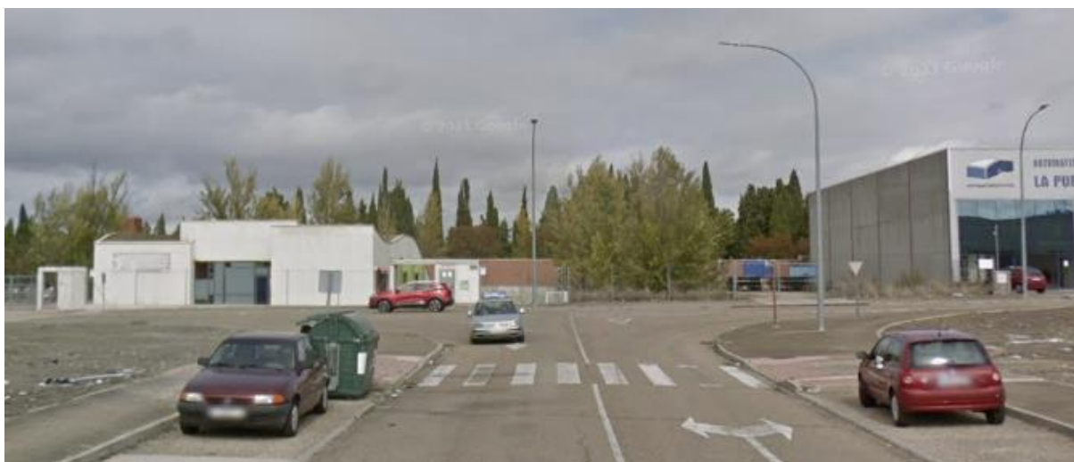
Ilustración 60: Paso peatonal sin señalización vertical en la calle Orfebres
